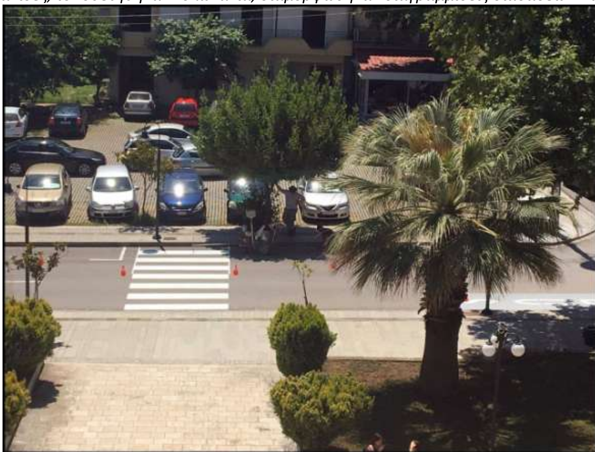
Εικόνα 6: 1 η Φάση Εργασιών (διαγράμμιση) Οδός Ταγμ. Βελισσαρίου / Φιλιππιάδα
