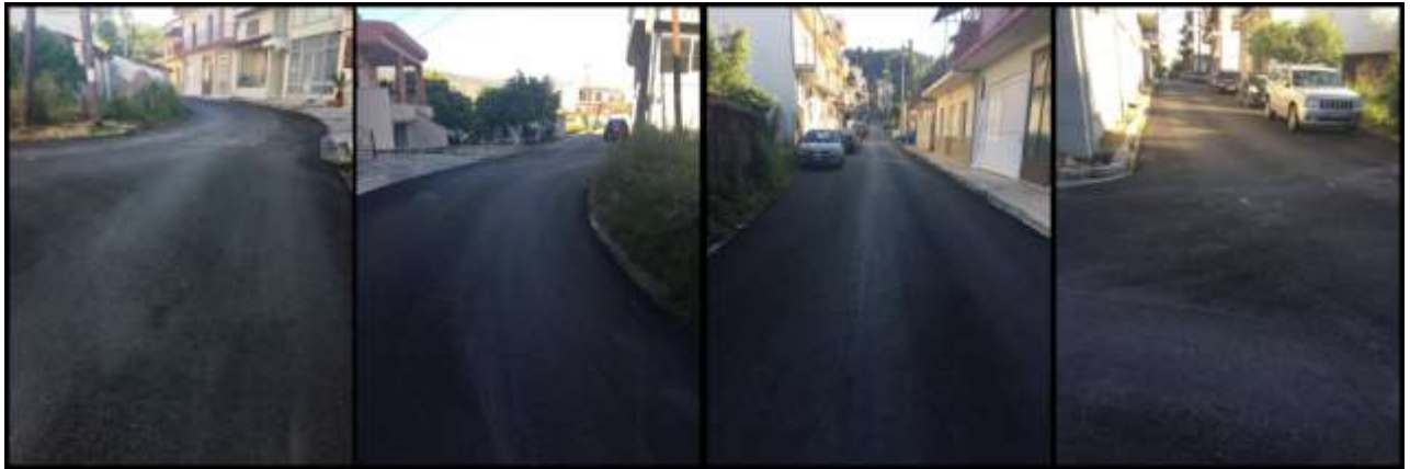
Εικόνα 1: 1 η Φάση Εργασιών (ασφαλτόστρωση) Οδός Γριμπόβου / Φιλιππιάδα
