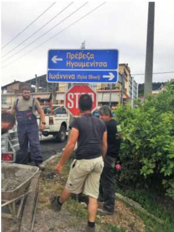
Εικόνα 4: Τοποθέτηση Πινακίδων Οδός Τζαβέλλα / Φιλιπιάδα
