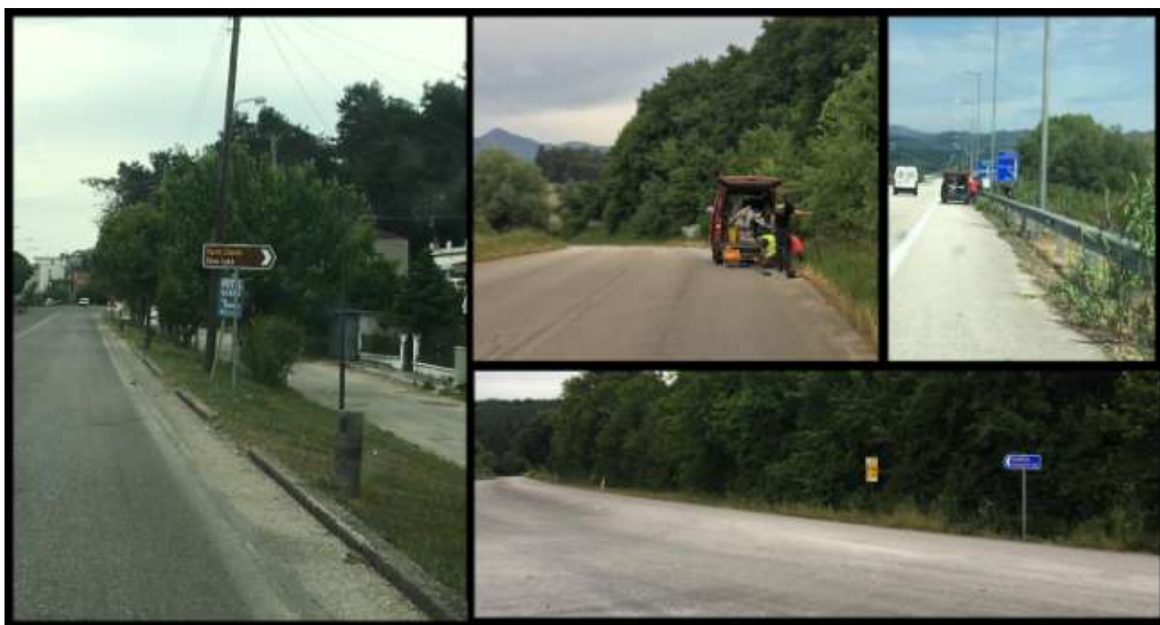
Εικόνα 5: τοποθέτηση πινακίδων σήμανσης
