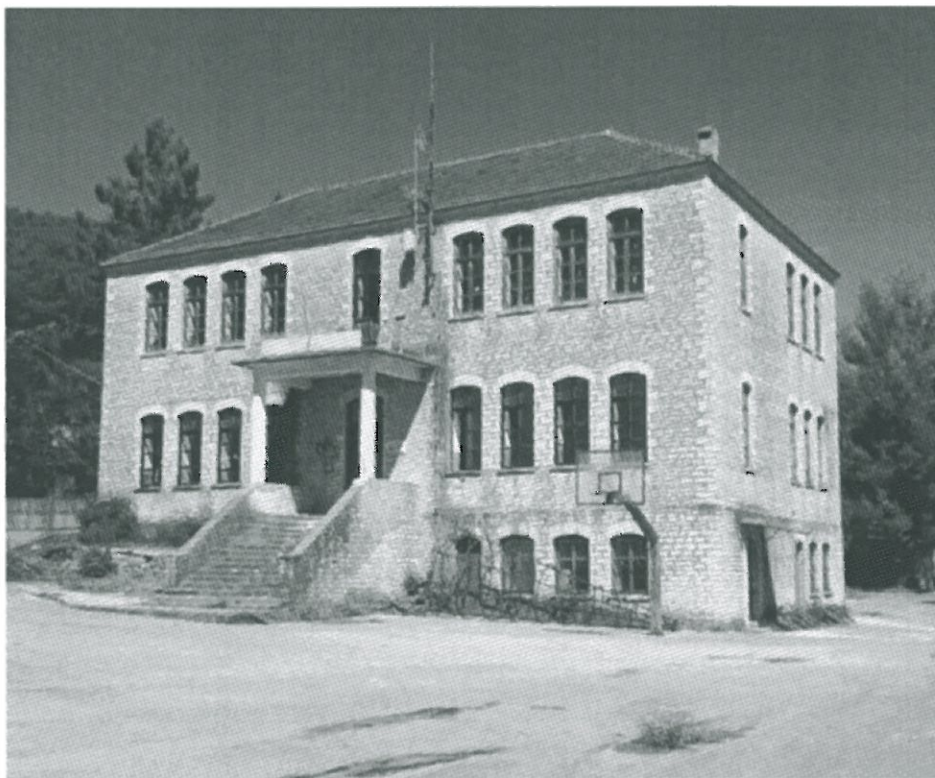
Εικόνα 3 Άποψη της νότιας (κύριας) όψης του κτιρίου
